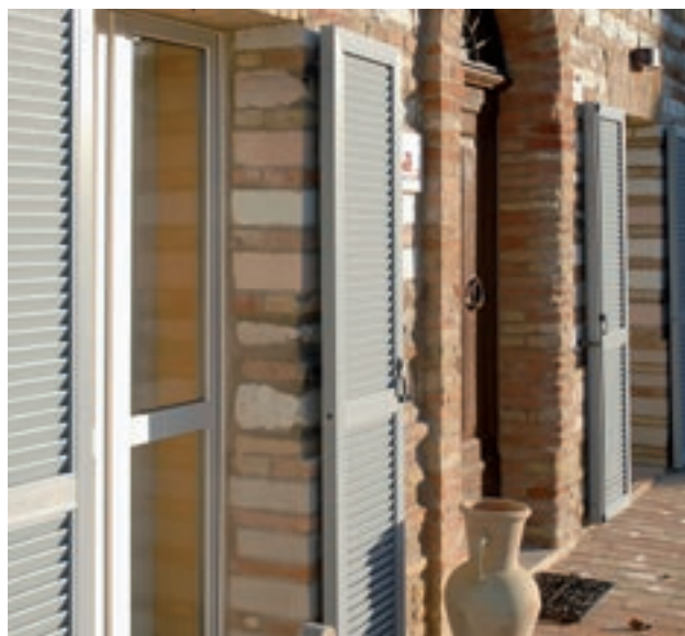
Realizzazione di Tecnoplast Infissi
